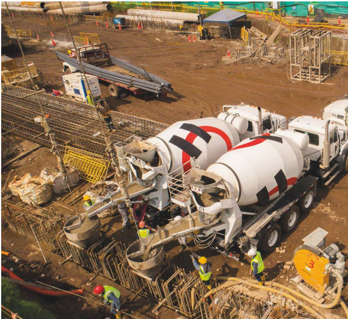
Colocación armadura y hormigonado mediante tubo tremie
