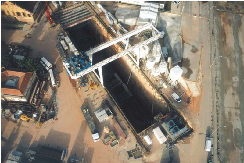
Línea 9 del Metro de Barcelona
