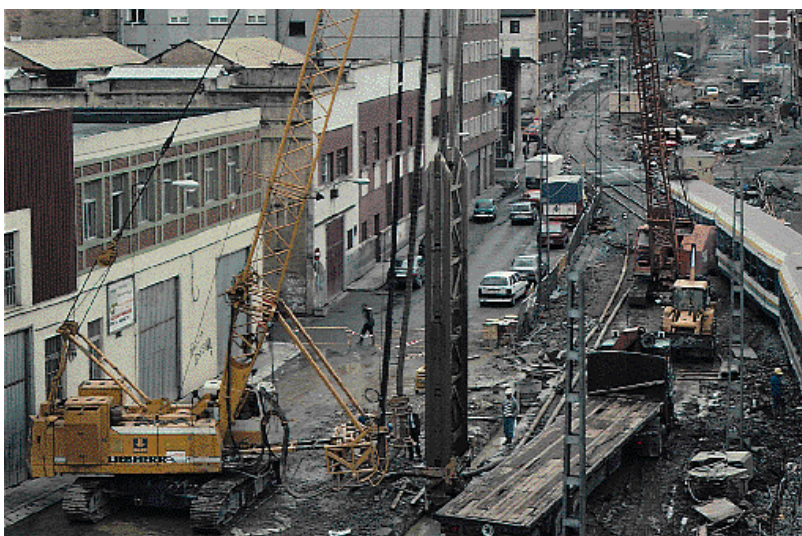
Soterramiento de la Línea de Ferrocarril en Erandio (Bilbao)
