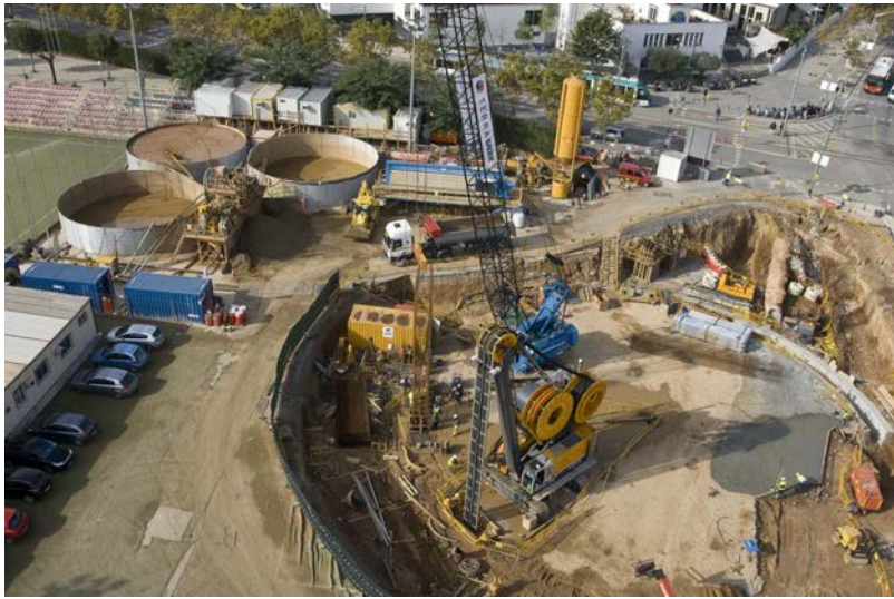
Pantallas con Hidrofresa para las Estaciones-Pozo de la Línea 9 del Metro de Barcelona
