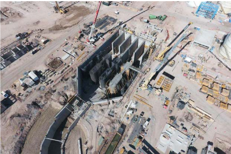
Central Ciclo Combinado Empalme I, Sonora (México)
