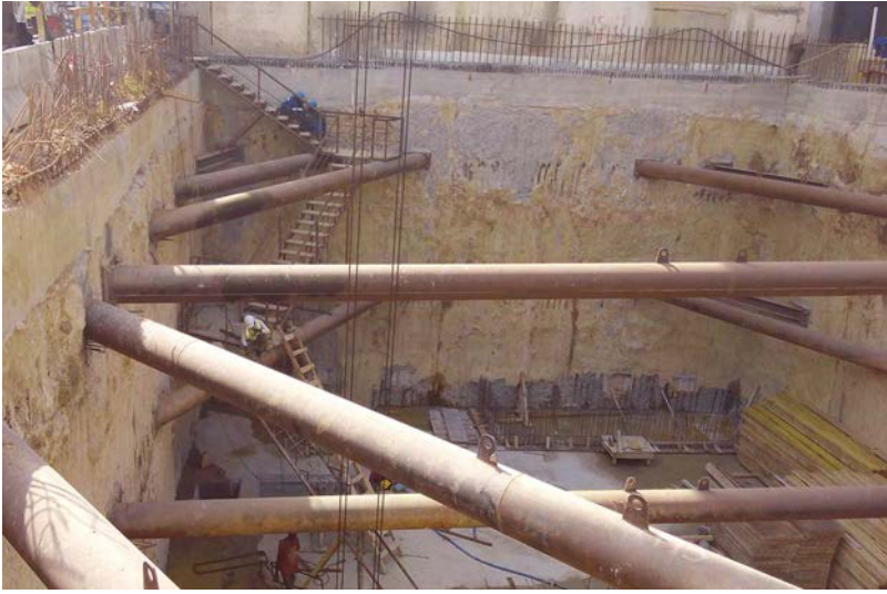
Muro Pantalla para edificio de oficinas "IPRES" en la Plaza de la Independencia Dakar (Senegal)
