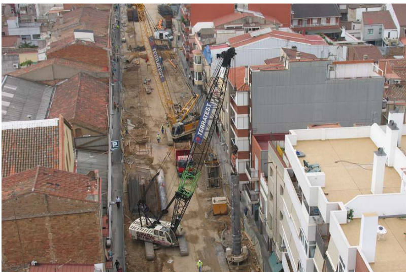
Línea 2 del Metro de Barcelona
