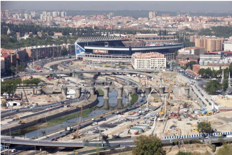
Soterramiento de la M-30 Puente de San Isidro - Puente de Praga Puente de Praga - Nudo SUR
