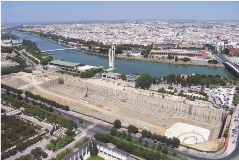
Centro de Servicios Terciarios Ubicado en Parcela CTI del Per-Ari CT-10 (Sevilla)
