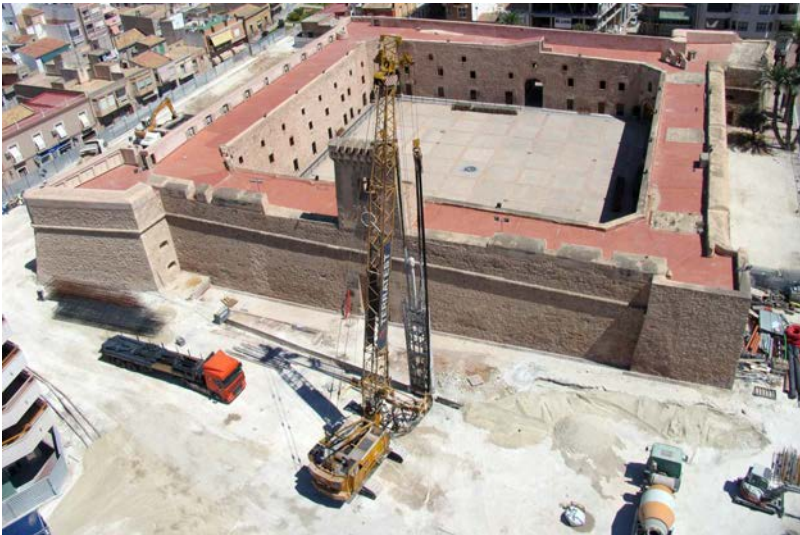
Línea 3 y 5 del Aparcamiento subterráneo en Plaza de la Glorieta (Alicante)
