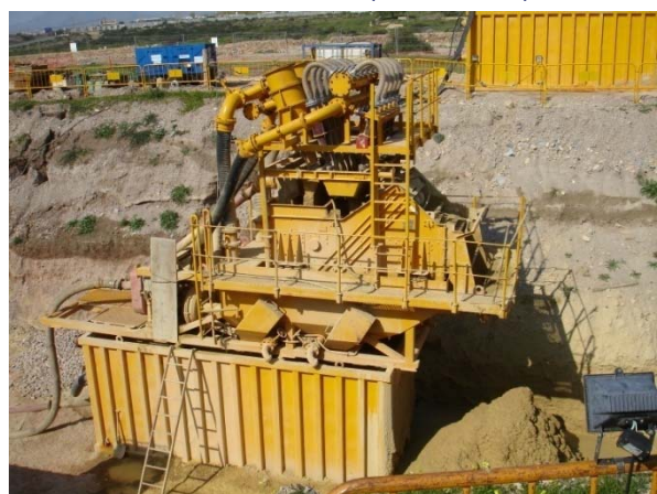
Planta de separación del material extraído
