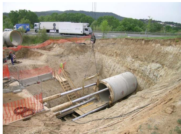
Tuneladora cruzando bajo carretera
