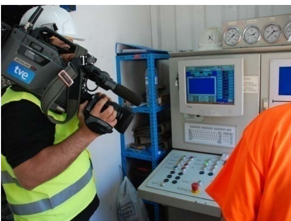
Cuadro de mandos de tuneladora situado en superficie
