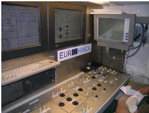
Cabina de control de tuneladora EPB
