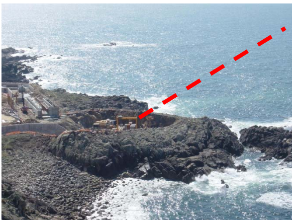
Pozo de ataque de emisario submarino. A Coruña
