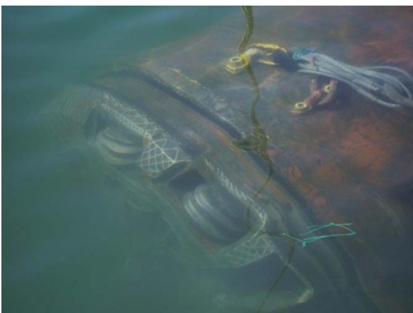
Rescate de tuneladora tras emisario submarino
