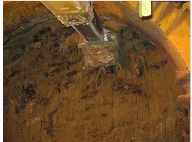
Frente de excavación de escudo abierto con excavadora
