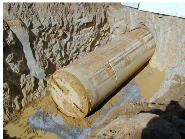
Salida de tuneladora en pozo de recepción
