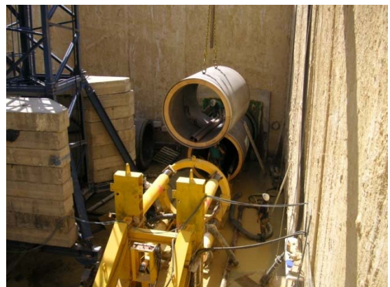
Colocación de un tramo de tubería para hincar
