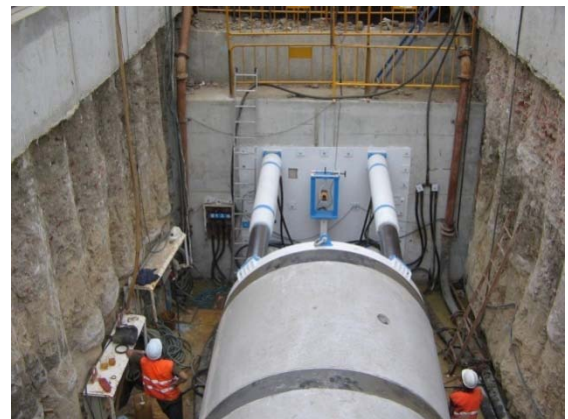
Pozo de ataque con sistema de empuje
