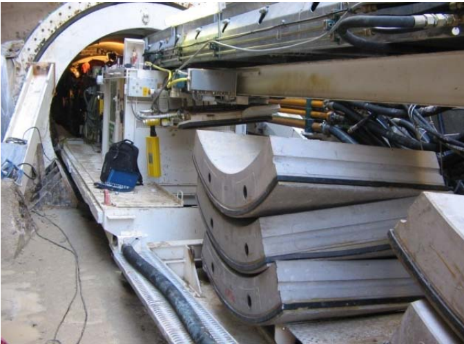
Dovelas en back up de tuneladora
