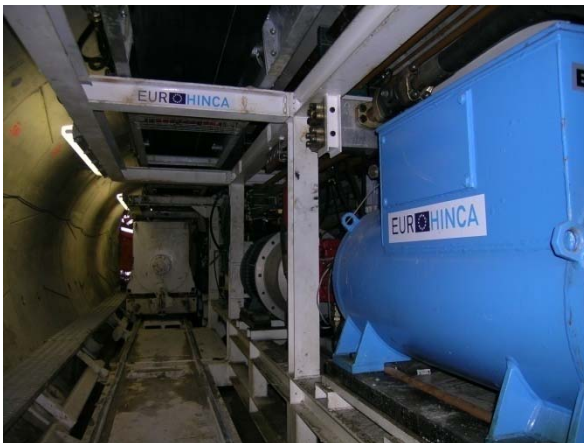
Back up de tuneladora EPB en interior del túnel
