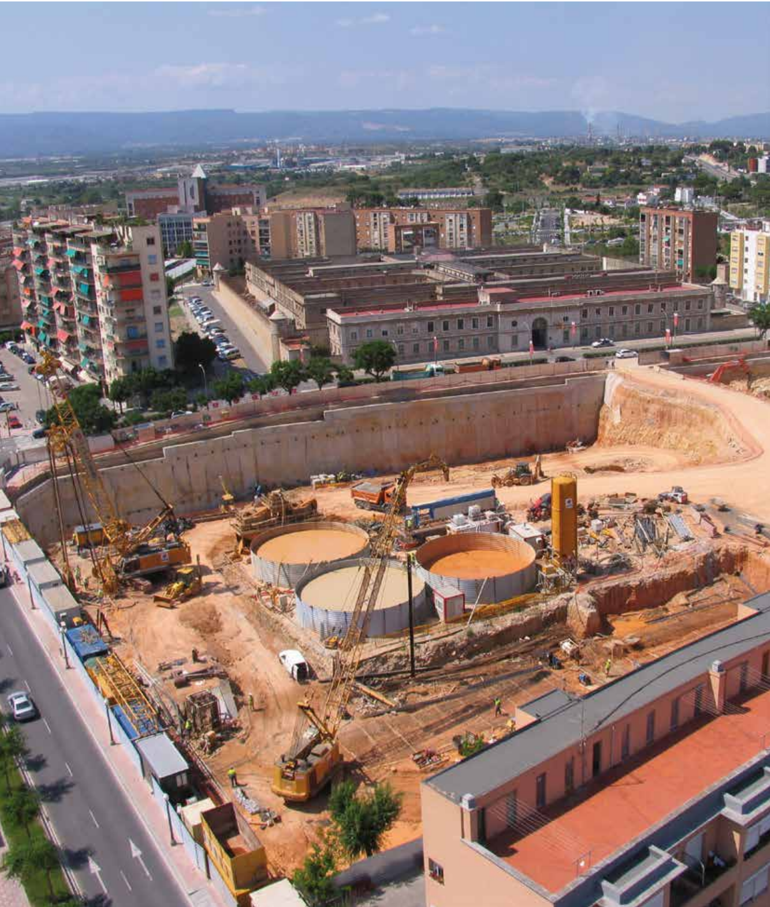
Corte Inglés Mall, Tarragona, Spain Diaphragm walls
