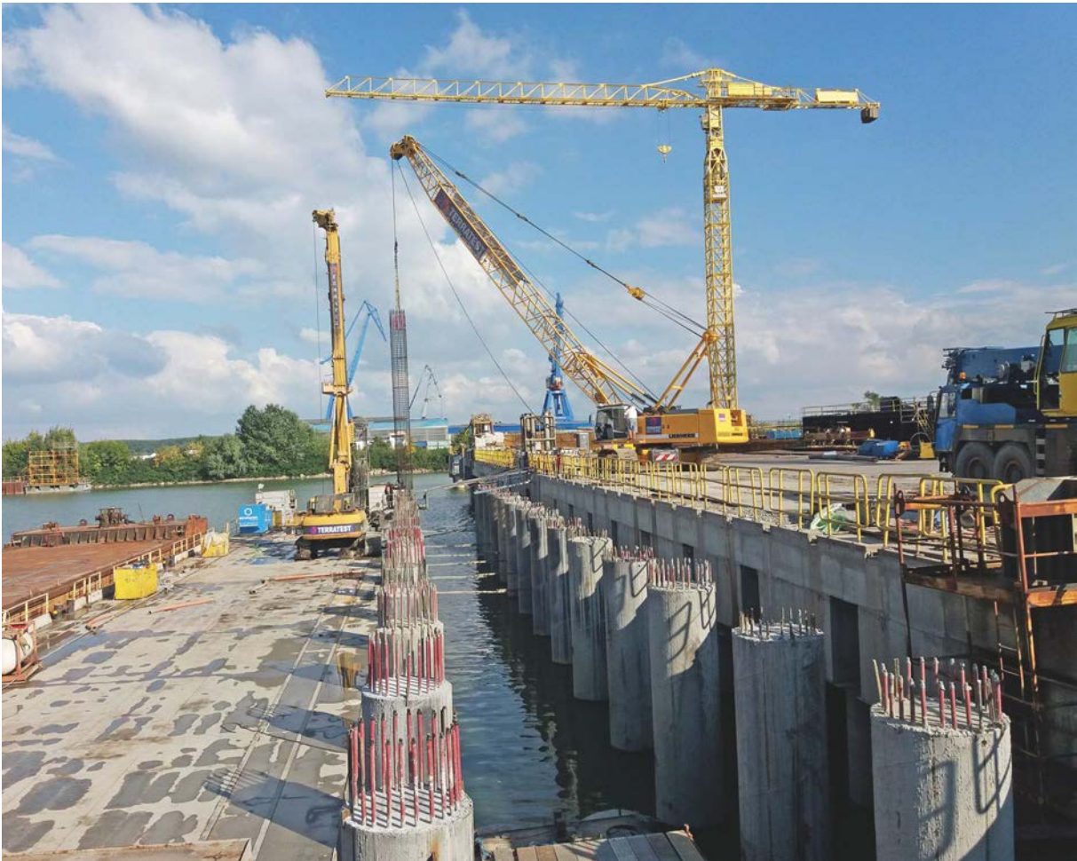
Ampliación del muelle, Puerto de Tulcea, Fase 4+5, Rumania
