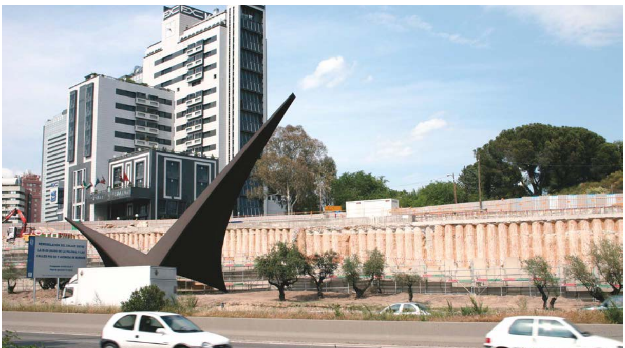
Contención mediante Cortina de Pilotes in situ para Centro Comercial El Corte Inglés en Pamplona (Navarra)
